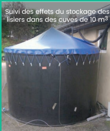
Couverture d'une fosse de stockage de lisier permettant la collecte du méthane (méthanisation passive)
